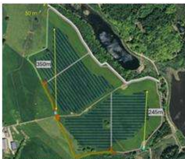
Figure 3 - Distance des panneaux éloignés par rapport aux clôtures incendies
